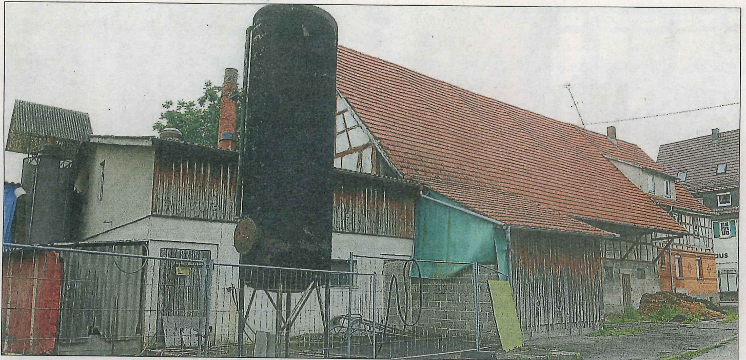
Die Gebäude des ehemaligen Schweinemastbetriebs in der Haidlingsgasse mitten in Walddorf konnte die Gemeinde Walddorfhäslach jetzt erwerben. Damit ist der Weg frei für eine umfassende Sanierung der Walddorfer Ortsmitte.
